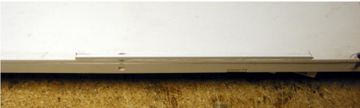
Ein Winkelprofil wird am Boden festgeklebt, das Andere oben in der Aussenwand. U.U. müssen die Schiebetüren oben und unten etwas angeschrägt werden, damit diese leichter in den Führungen laufen.
